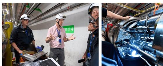
写真8：LHC 真空系へのヘリウム漏れの修復作業は、複数の専門家チームの連携により10日間で解決
