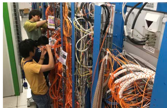
(写真 2) 新しいミュオントリガー回路を実験室に設置し、データ転送のための光ファイバーを接続
